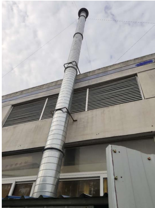
光氧+活性炭吸附装置+15m 高的排气筒
